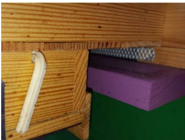
Slika 7: Izboljšan prototip z odvajanjem zraka iz notranjosti panja (Foto: Noč, B.)
