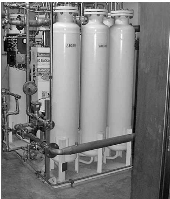
Slika : Enota za čiščenje in nadgradnjo bioplina do faze biometana na bioplinski kmetijski napravi (foto OKT)
