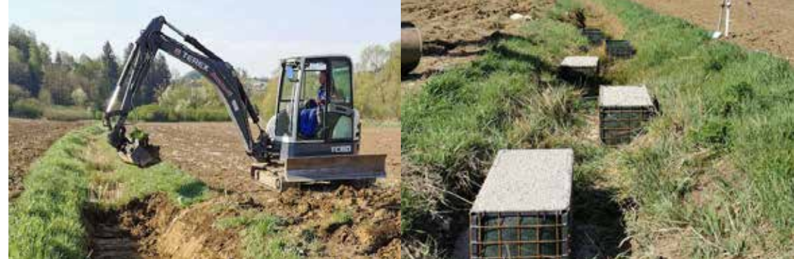
Slika 3: Izgradnja grajenega ekosistema; od leve sedimentacijski bazen, odsek umetnega meandriranja, čistilna greda; Meja Šentjur, Ponikva (Limnos 2020)
