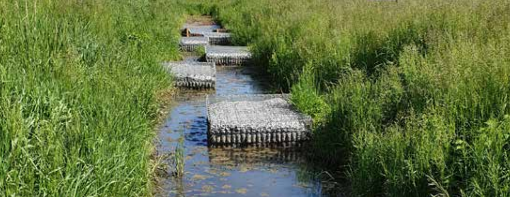
Slika 9: Grajeni ekosistem, odsek z umetnim meandriranjem, prvo leto po izgradnji, Jablje, 11. 5. 2021 (Limnos 2021).
