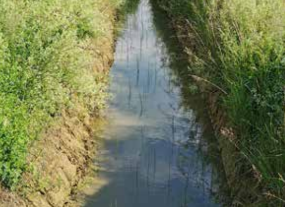
Slika 7: Grajeni ekosistem 2 meseca po izgradnji, levo sedimentacijski bazen, desno čistilna greda; Ponikva (Limnos 2020)
