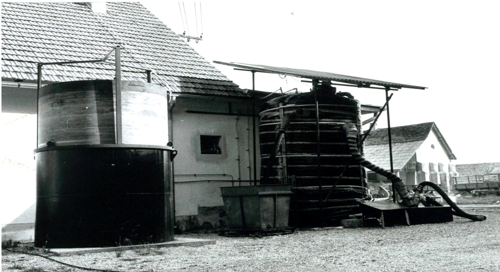
Eksperimentalna bioplinska naprava – Jablje, iz začetka osemdesetih let prejšnjega stoletja Zavod za mehanizacijo kmetijstva – današnji Oddelek za kmetijsko tehniko in energetiko
