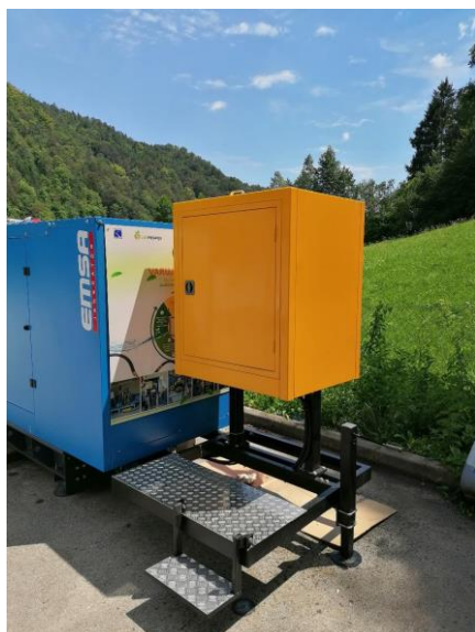
Slika 5: Agregat električne moči 110 kW s pogonom na očiščeno odpadno jedilno olje proizvaja zeleno električno energijo, za delovanje agregata je namenjen modularni sistem AIS OIL ELGENER 21.
