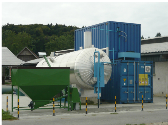
Mikro bioplinska naprava (modularne izvedbe) v Jabljah je plod skupnega razvojnega dela podjetja Omega Air in Kmetijskega inštituta Slovenije
