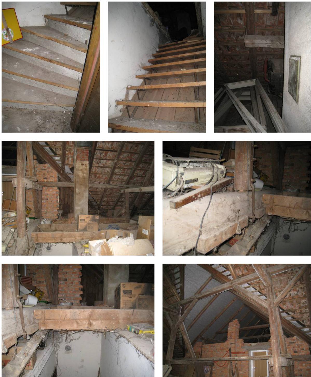
Slike 8-14: Trakt B, dostop do podstrešja, podstrešje in strešna konstrukcija
