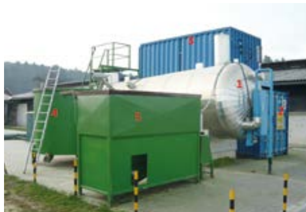
Mikro bioplinjska naprava z dodatnim sistemom za čiščenje in nadgradnjo bioplina do faze biometana, 1 – digester, 2 – nadgradnja bioplina do faze biometana, 3 – zalogovnik plina, 4 – hidrolizna posoda, 5 – enota za doziranje odpadne trdne biomase
