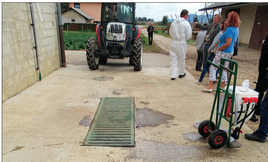
Betonska ploščad za polnjenje naprav za nanašanje FFS in za zunanje pranje – čiščenje naprav onesnaženih s FFS. Na sredi je kanal, kjer se zbira odpadna kontaminirana voda in se nato prečrpa v sistem za čiščenje.
