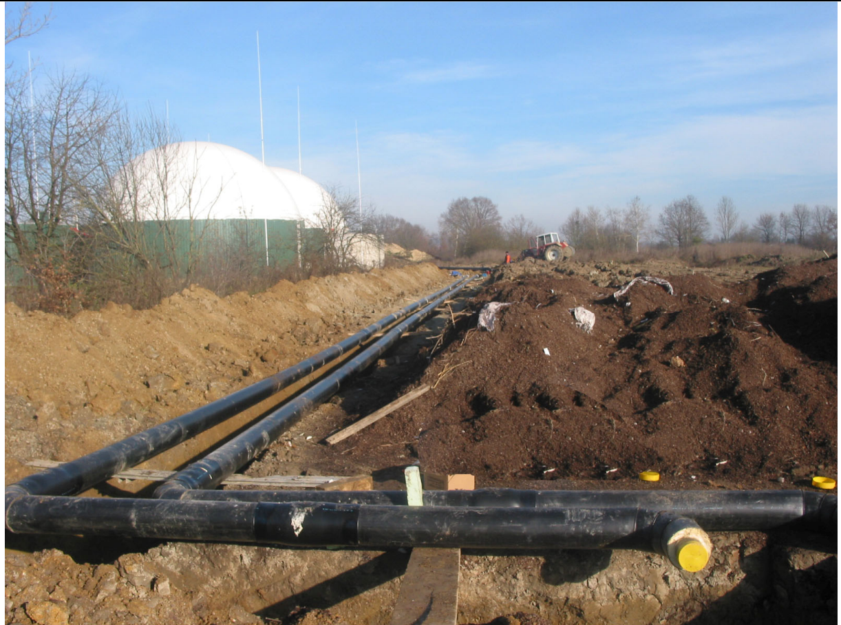
Izgradnja toplovoda pri bioplinarni
