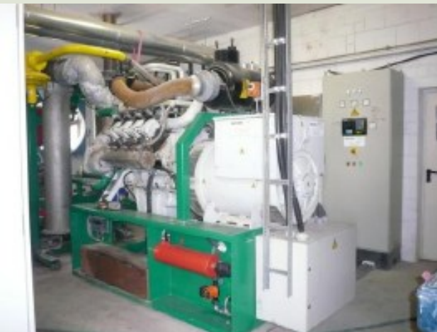
Ena od obeh kogeneracijskih naprav, inštalirana kot del prvotnega razvoja, ki pa jo sedaj uporabljajo samo kot rezervo
