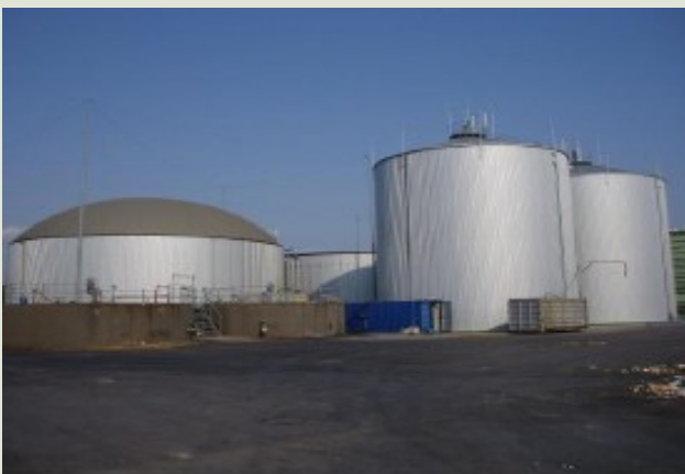
Dva primarna digestorja iz nerjavečega jekla (desno) & in sekundarni digestor za hrambo plina (zadaj levo)
