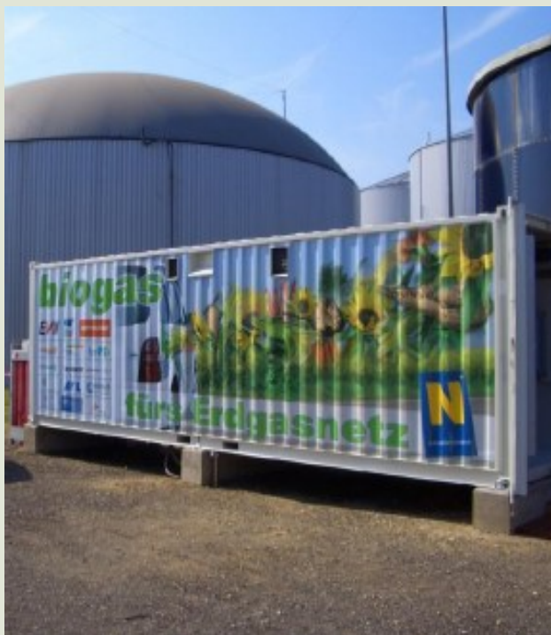
Zunanji in notranji pogled na bioplinsko nadgrajeno napravo v Bruck/Leithi, ki prikazuje kompresor, izmenjevalce toplote (desno) in membranske module (levo)
