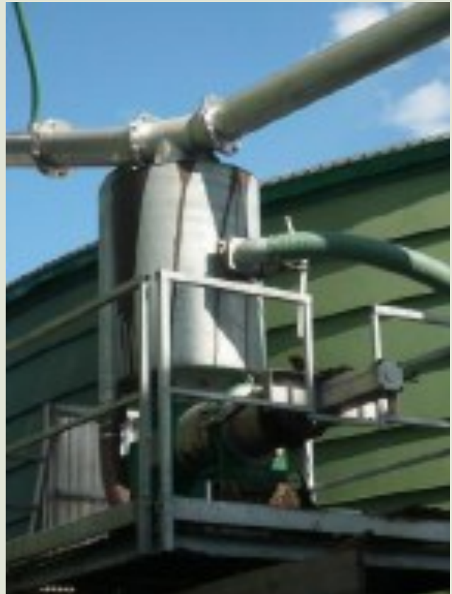
Ločevalnik trdnih delcev digestata
