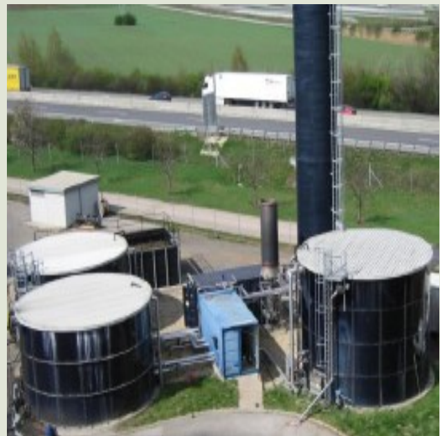
Puferni rezervoarji za tekoči material (levo), rezervoar za površinsko vodo (desno)
