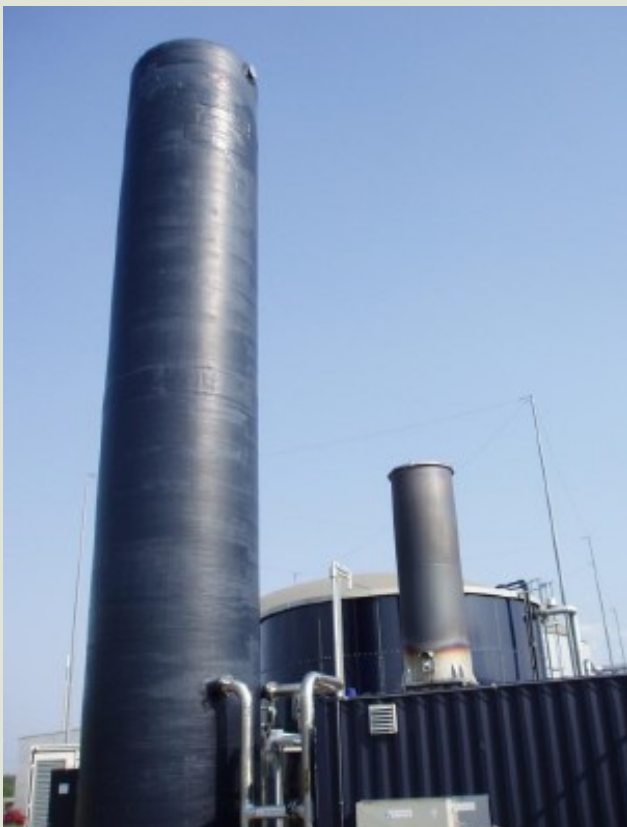
Biološki pralnik scrubber za razžvepljevanje surovega bioplina
