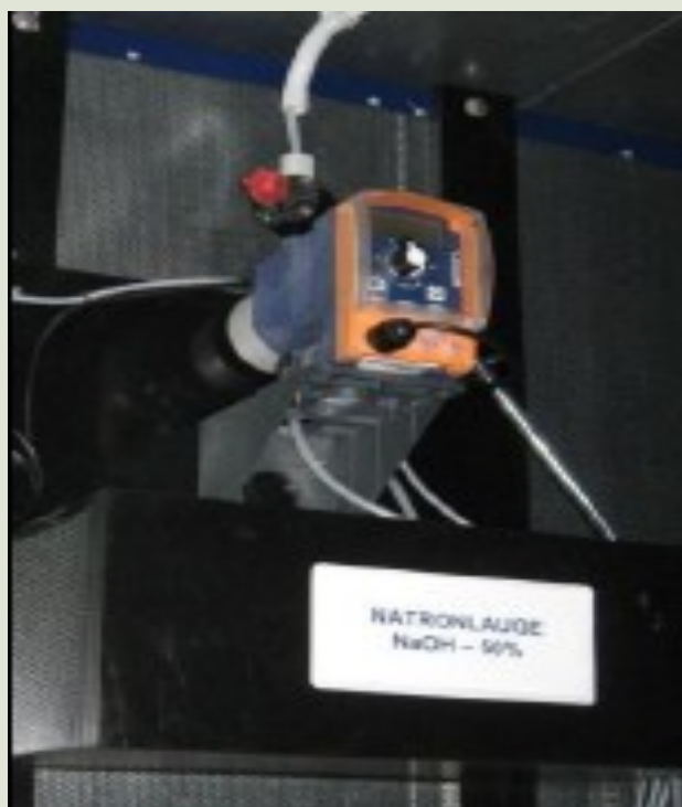
Črpalka za doziranje natrijevega hidroksida
