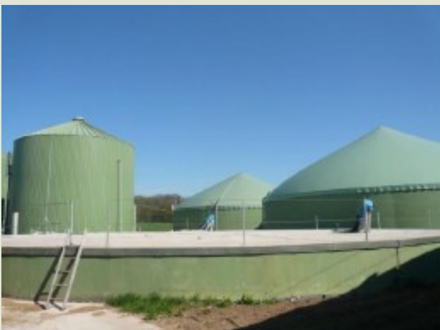
Tri razvojne faze (i) zadaj levo Lipp GmbH, (ii) spre-daj, samoskonstruirani rezervoar, (iii) sredina zadaj & desno, Novatech GmbH
