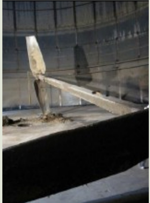
Centralni mešalnik primarnega digestorja
