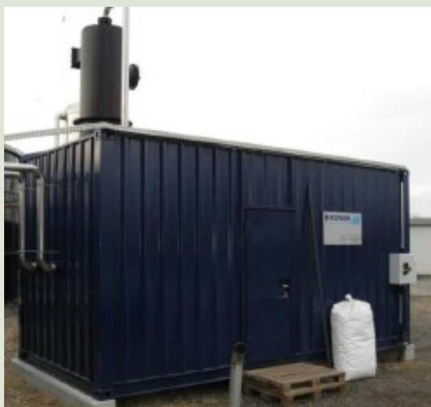
Zunanji izgled kemijsko-oksidacijskega pralnika scrubber za razžvepljevanje surovega bioplina
