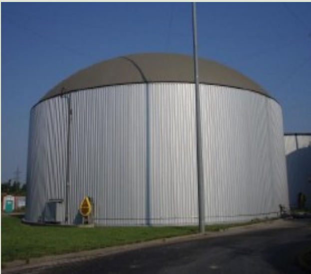
Sekundarni digestor in shranjevalnik plina
