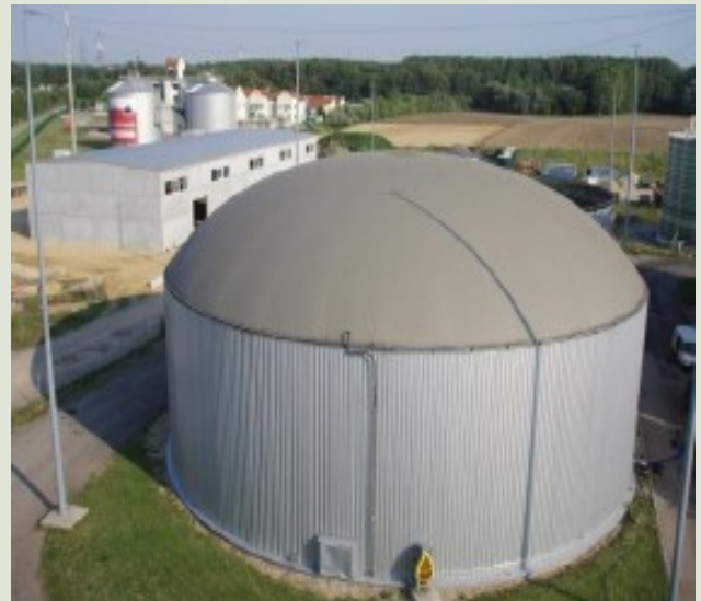
Sekundarni digestor in shranjevalnik plina
