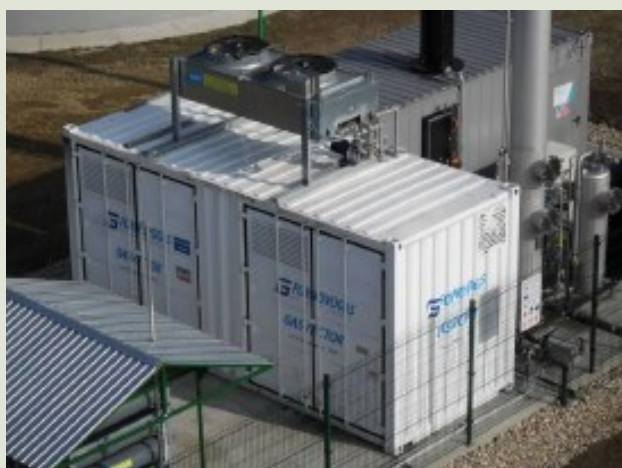
Enota za nadgradnjo bioplina v jeklenem kontejnerju ISO
