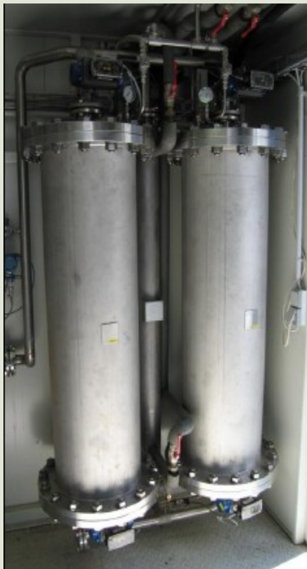
Absorberji iz železovega oksida za končno razžvepljevanje bioplina
