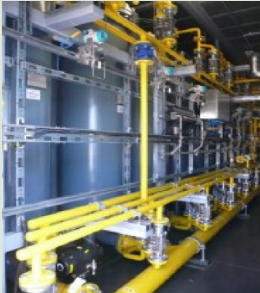
Puforni rezervoar za surovi bioplín (spredaj levo), x2 aktivirana ogljikova filtra (na sredini desno), rezervoar za shranjevanje biometana (zadaj levo)
