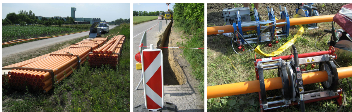
Slika 10: Plinovod za biometan v kraju Bruck/Leitha v Avstriji med polaganjem; povezava cevi z varjenjem (desno); Vir: Vienna University of Technology
