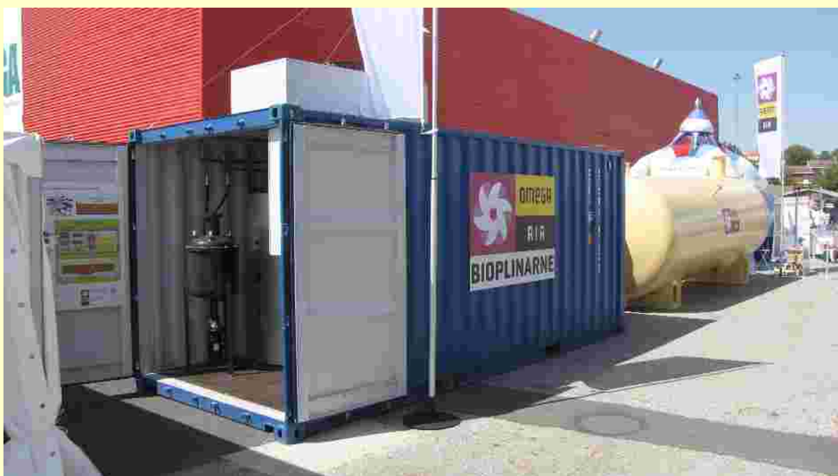
Pogled v strojnico Mikro bioplinske naprave kontejnerske izvedbe (Omega air, Ljubljana)
